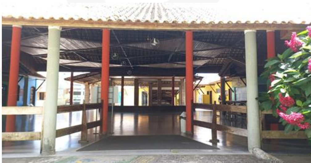
Figura 70 - 16º Registro fotográfico sobre a Infraestrutura Física
